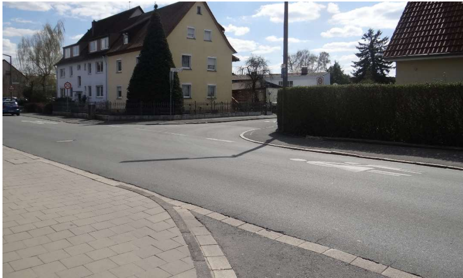
● Abbildung 13: Fehlende Querungshilfe über die Äußere Tennenloher Straße auf einem wichtigen Schulweg (Einnündung Borsigstraße)
